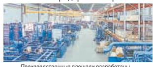
Производственные площади разработаны для изготовления агрегатов
